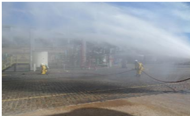
Funcionamento do sistema de contenção de nuvem de gás
